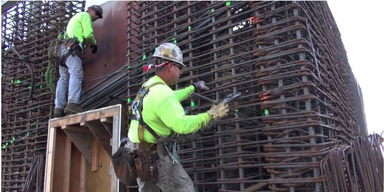
Gambar 1 – Beberapa Pekerja yang Sedang Merangkai Tulangan Shearwall di Lapangan
